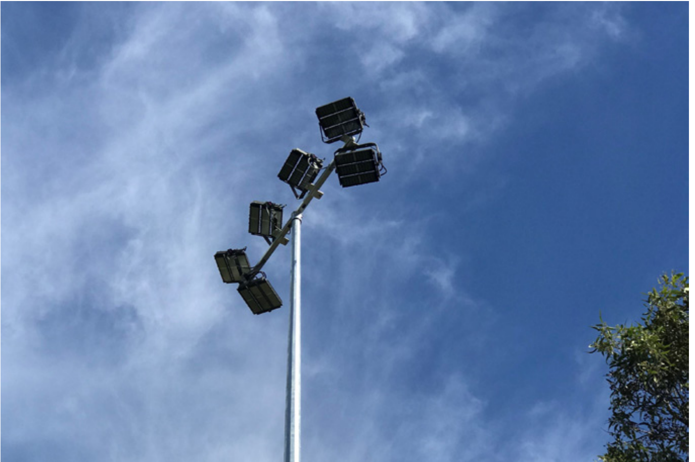
Ellersdale Park (Warwick)
